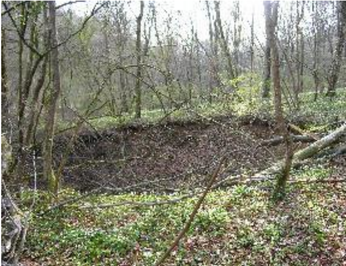
Effondrement localisé au droit d'une ancienne mine de fer de Lorraine -Source Ineris
