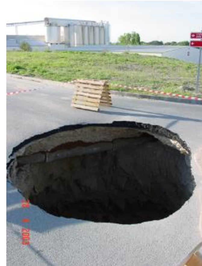
Effondrement localisé au droit d'une ancienne carrière de craie - Source Ineris
