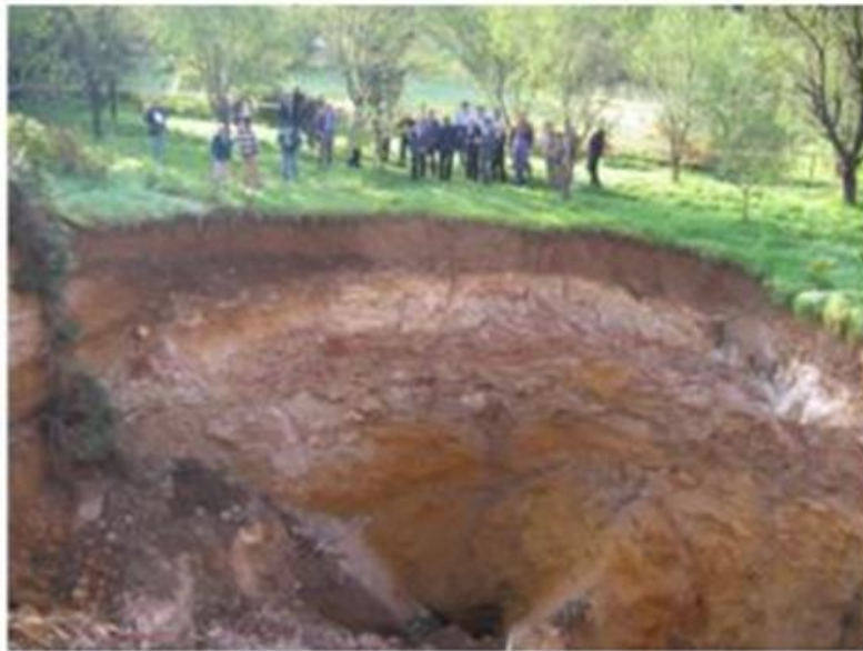
Exemple d'effondrement localisés au droit de cavités d'origine anthropique - source : Ineris
